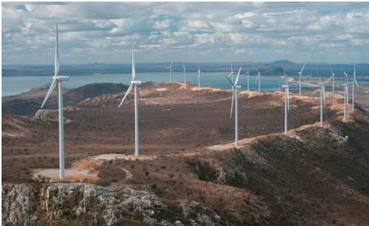
Figura 3 – Parque eólico Pedra do Reino, Sobradinho-BA
